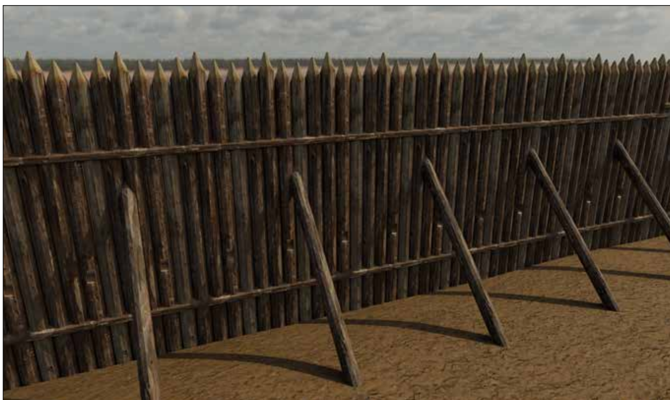
Рис. 40. Компьютерная модель острожной тыновой стены
