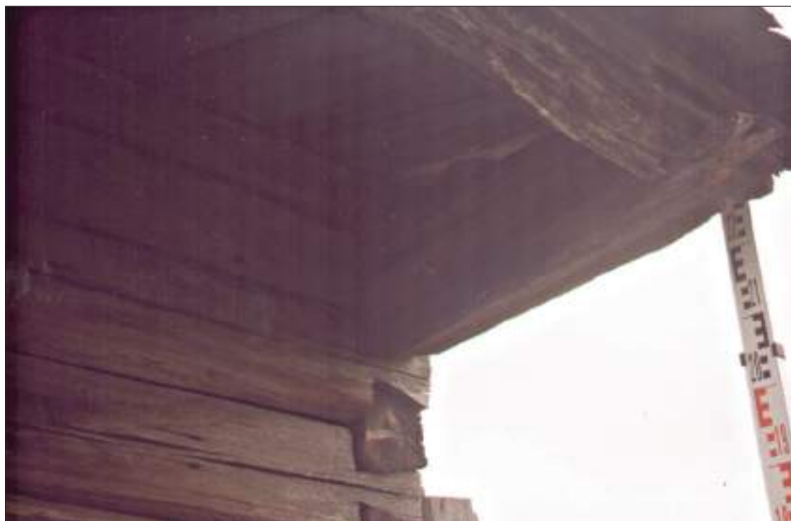
Рис. 18. ХМАО-Югра. Сургутский район, пос. Сайгатино. Дом Махневой (Очимкиной). Фрагмент южного фасада. Фрагмент прируба. Консольный вынос кровли прируба над входом с восточной стороны
