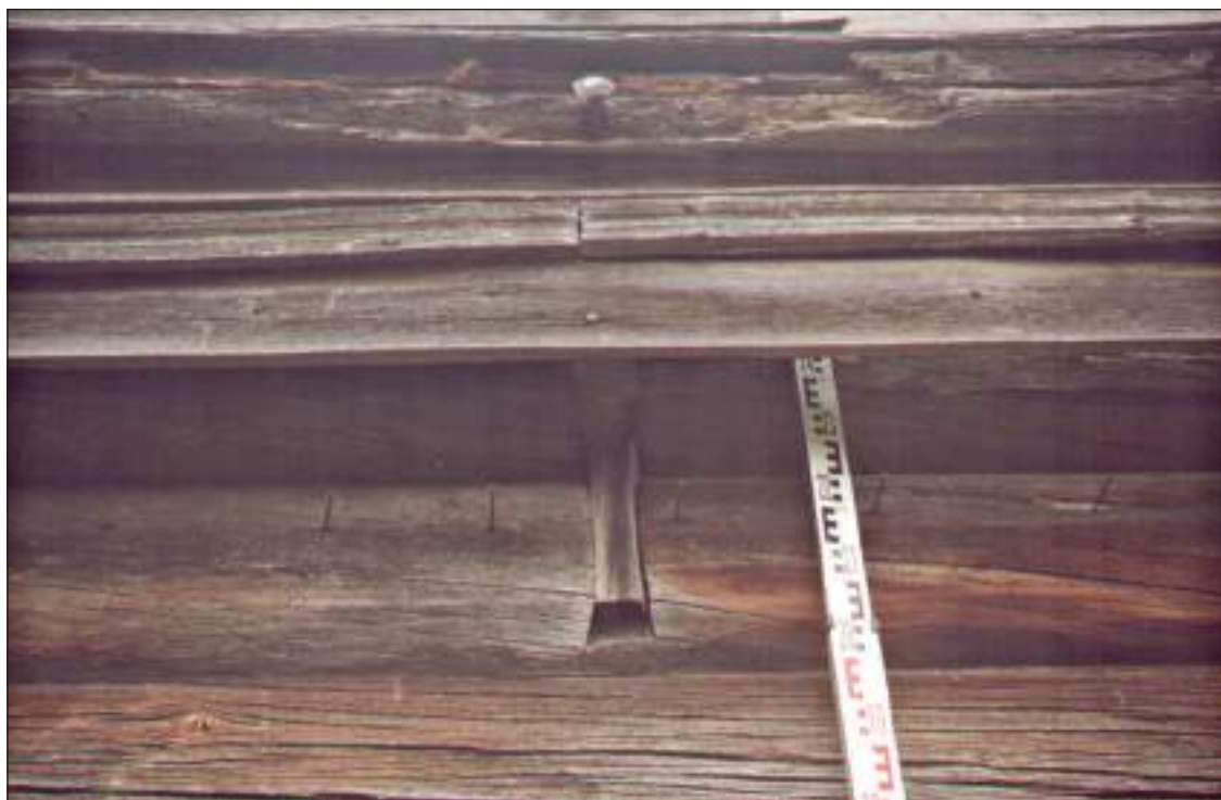
Рис. 27. ХМАО-Югра. Сургутский район, пос. Сайгатино. Дом Махневой (Очимкиной). Фрагмент северного фасада. Фрагмент составного прибивного карниза. Кронштейн, врубка «ласточкин хвост»
