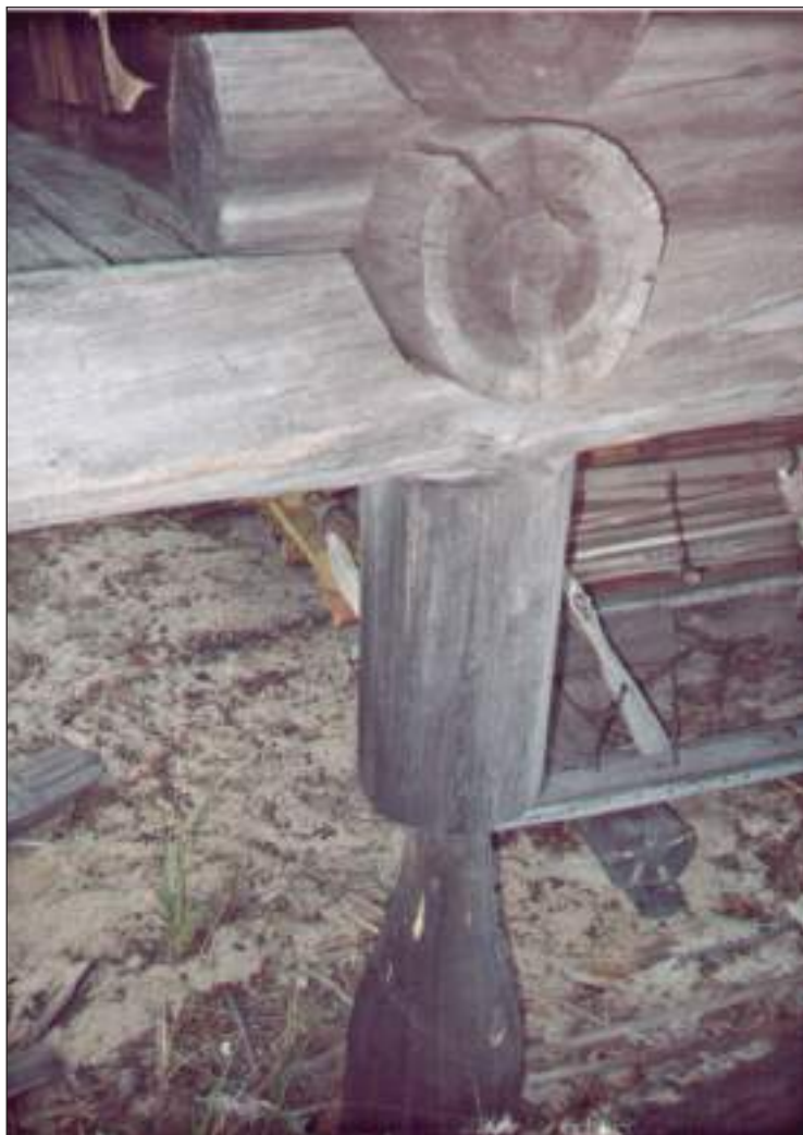
Рис. 66. ХМАО-Югра. Нефтеюганский район, юрты Пунси. Продуктовый свайный лабаз Е. Д. Каюкова. Фрагмент юго-восточного фасада. Узел опирания сруба на сваю (лану). Хорошо виден способ рубки стен, продольный желоб в бревнах выбран слабо, практически отсутствует Fig. 66. KhMAO-Yugra. Nefteyugansk District. Punsu yurts. Food pile labaz of E. D. Kayukov. Fragment of the south-eastern facade. The support unit of the log house on the pile (lana). The method of wall construction is clearly visible, the longitudinal groove in the logs is shallow, practically absent
