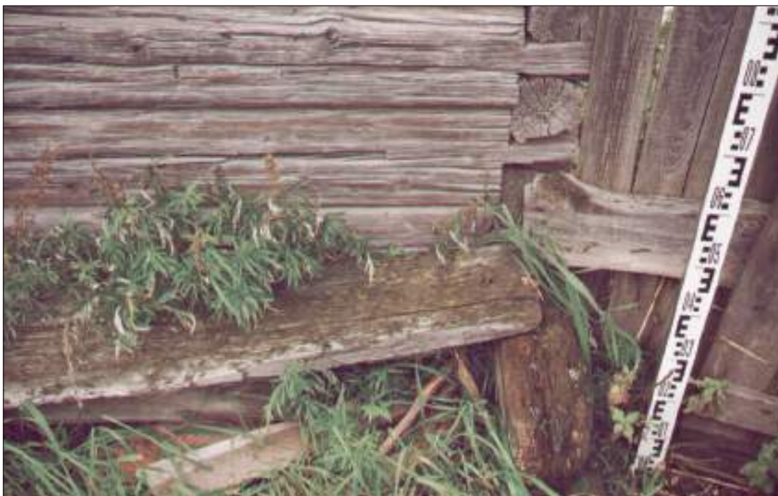
Рис. 16. ХМАО-Югра. Сургутский район, пос. Сайгатино. Дом Махневой (Очимкиной). Фрагмент южного фасада. Фрагмент прируба. Рубка «в лапу». Вынос нижнего венца прируба
