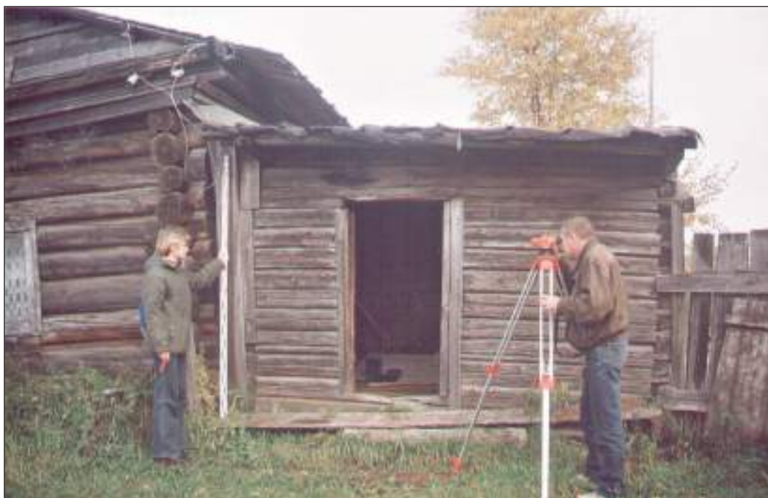
Рис. 10. ХМАО-Югра. Сургутский район, пос. Сайгатино. Пробивка «нулевой» отметки на фасадах с помощью нивелира
