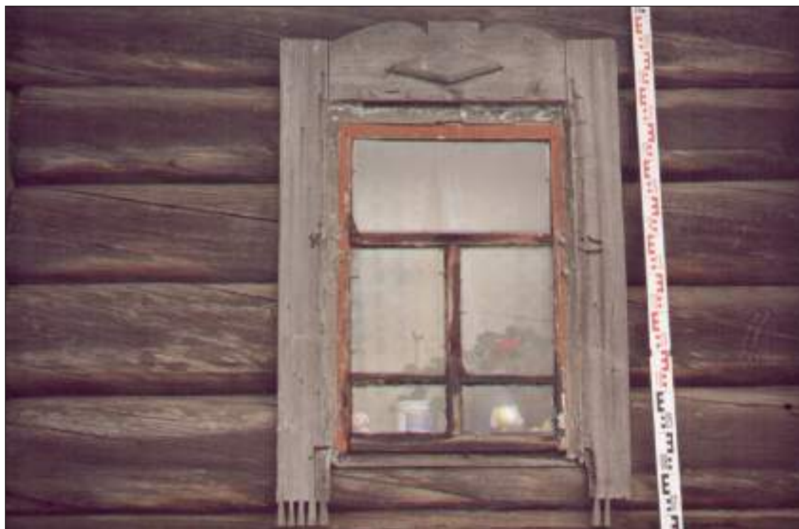
Рис. 21. ХМАО-Югра. Сургутский район, пос. Сайгатино. Дом Махневой (Очимкиной). Фрагмент восточного фасада. Правое окно
