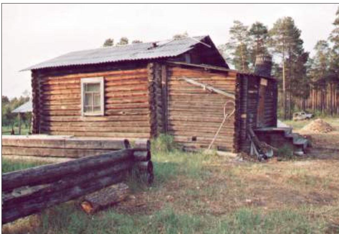
Рис. 59. ХМАО-Югра. Нefтеyуганский район, yрты Пунси. Изба Е. Д. Каюкова. Юго-западный фасад Fig. 59. KhMAO-Yugra. Nefteyugansk District. Punsı yurts. The log cabin of E. D. Kayukov. South-western facade
