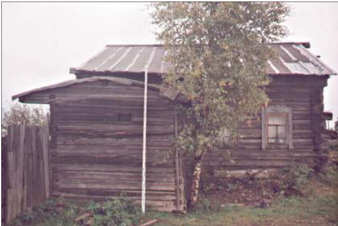
Рис. 16. ХМАО-Югра. Сургутский район, пос. Сайгатино. Дом Махневой (Очимкиной). Восточный фасад
