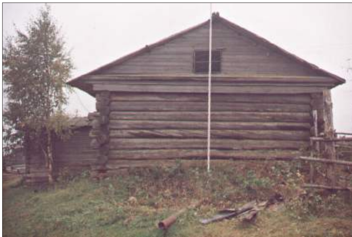
Рис. 13. ХМАО-Югра. Сургутский район, пос. Сайгатино. Дом Махневой (Очимкиной). Северный фасад Fig. 13. KhMAO-Yugra. Surgut District. Saygatino settlement. House of Makhneva (Ochimkina). Northern facade
