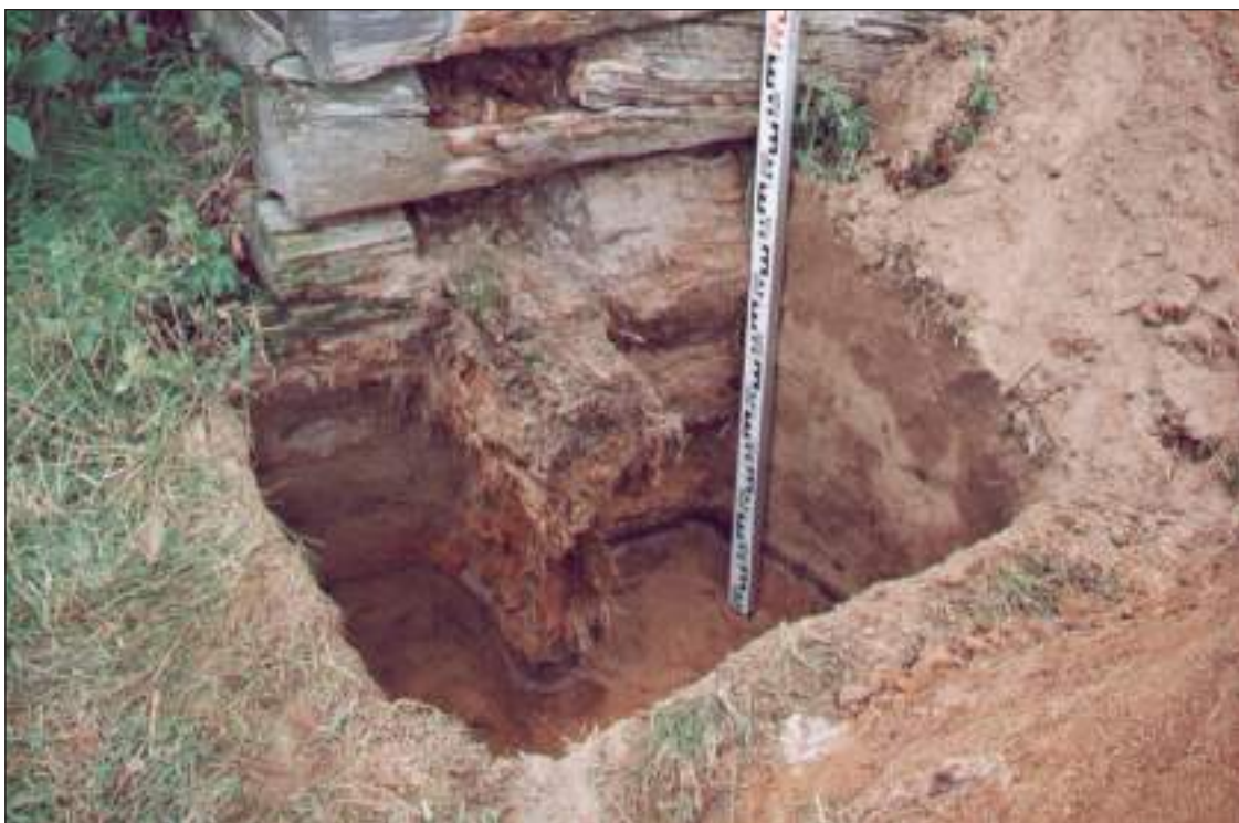
Рис. 23. ХМАО-Югра. Сургутский район, пос. Сайгатино. Дом Махневой (Очимкиной). Северный фасад. Стратиграфический разрез фундамента дома в районе северо-восточного угла. Шурф выполнен для определения нижнего венца дома
