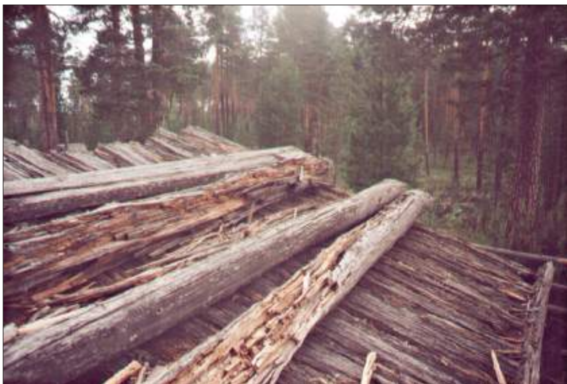
Рис. 67. ХМАО-Югра. Нефтеюганский район, юрты Пунси. Продуктовый лабаз Е. Д. Каюкова. Фрагмент кровли. Гнет Fig. 67. KhMAO-Yugra. Nefteyugansk District. Punsu yurts. Food pile labaz of E. D. Kayukov. Roof fragment. Roof beams
