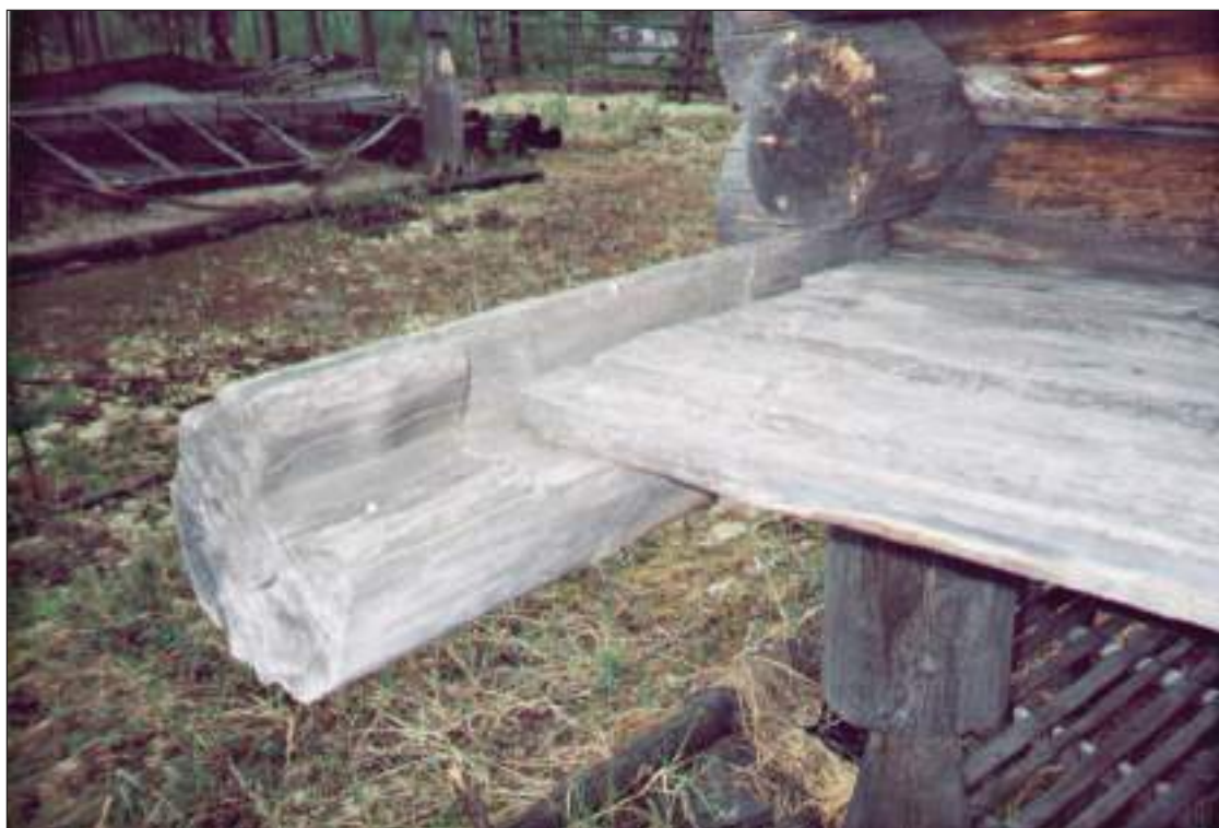
Рис. 69. ХМАО-Югра. Нefтеyуганский район, юрты Пунси. Продуlковый свайный лабаз Е. Д. Каюкова. Фрагмент юго-западного фасада. Узел опираиия плах пола предмостья
