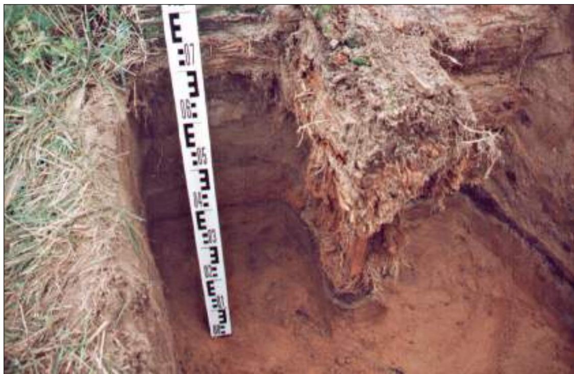
Рис. 25. ХМАО-Югра. Сургутский район, пос. Сайгатино. Дом Махневой (Очимкиной) Северный фасад. Закладка шурфа для определения нижнего венца прируба
