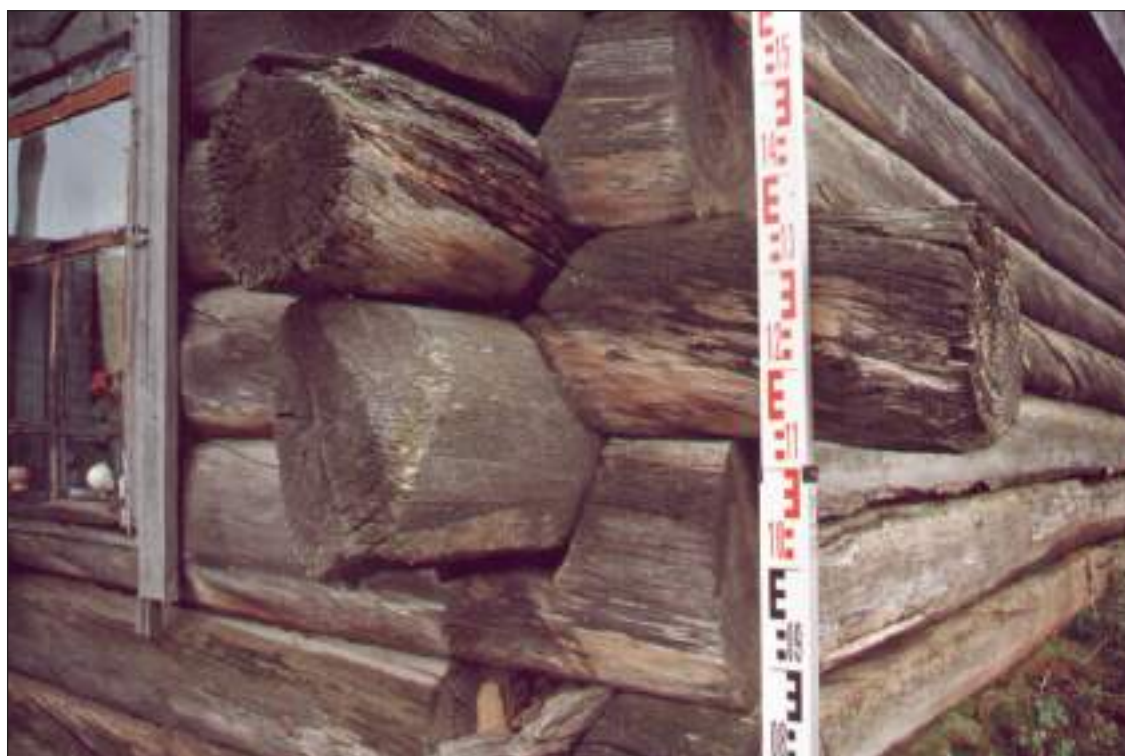
Рис. 22. ХМАО-Югра. Сургутский район, пос. Сайгатино. Дом Махневой (Очимкиной). Фрагмент восточного и северного фасадов. Вид с северо-востока. Выносы бревен сруба. Характерный вынос северного фасада
