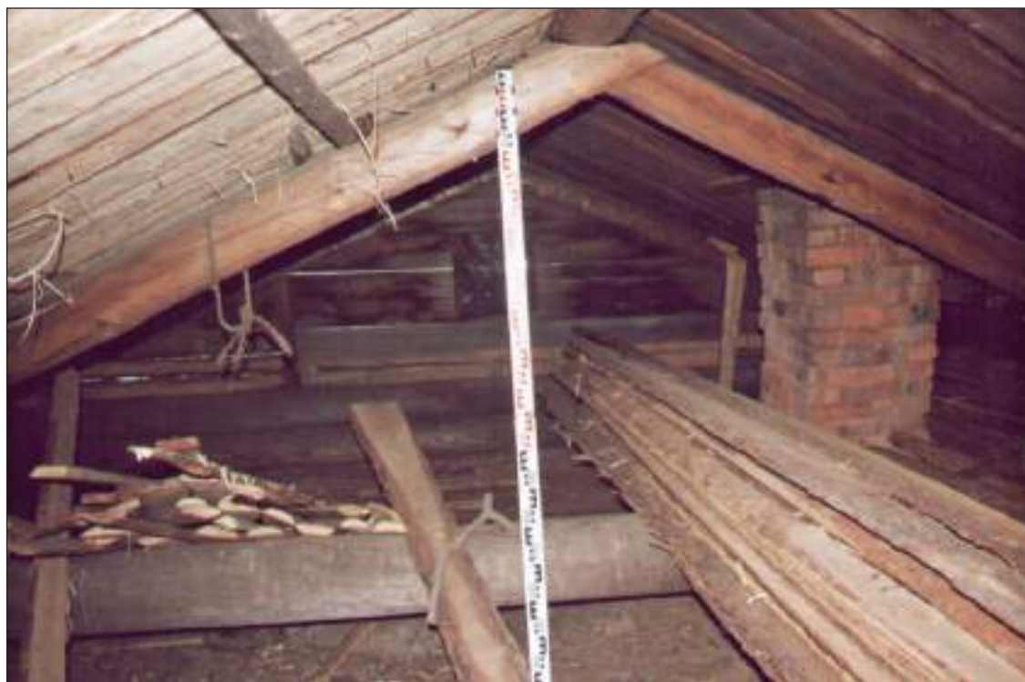
Рис. 30. ХМАО-Югра. Сургутский район, пос. Сайгатино. Дом Махневой (Очимкиной). Чердачное помещение. Вид изнутри на северный фронтон. Стропильные балки-затяжки. Стропильная конструкция крыши. Вывод печной трубы
