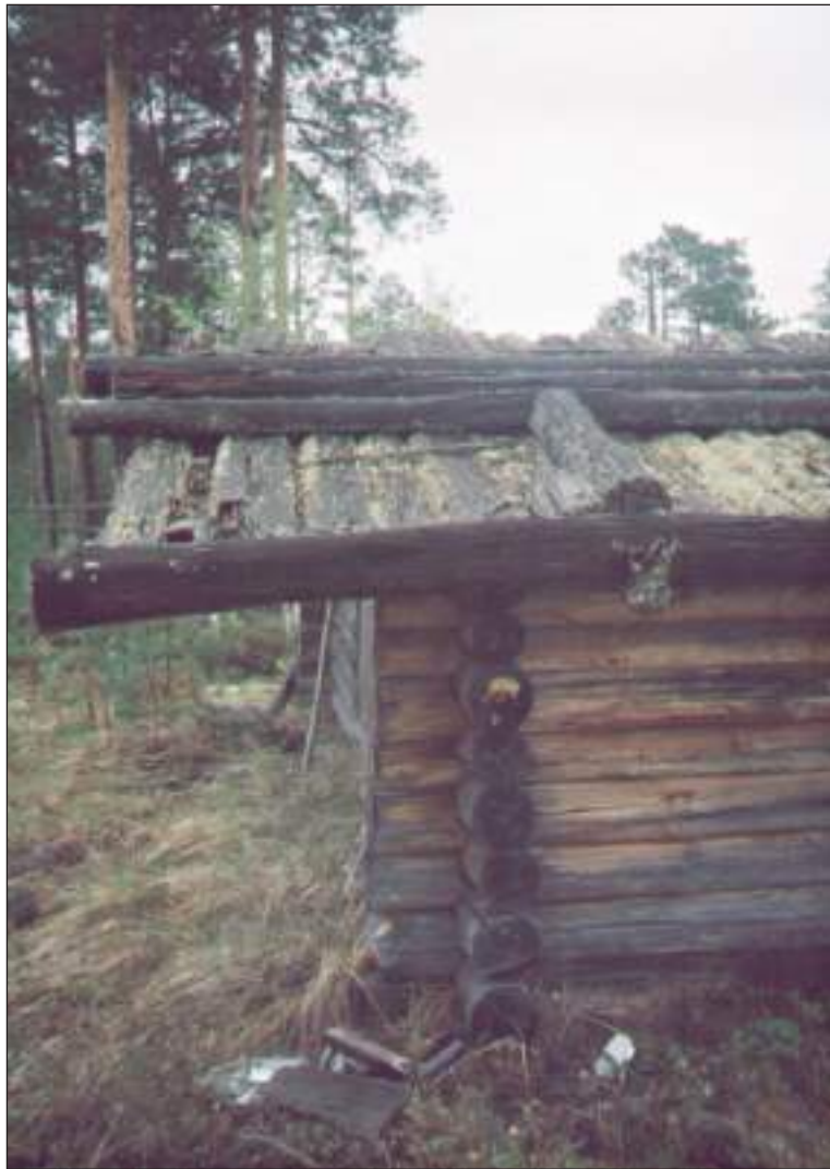
Рис. 75. ХМАО-Югра. Нефтеюганский район, юрты Пунси. Рыбный лабаз Е. Д. Каюкова. Фрагмент южного фасада. Кровельная конструкция на курицах и потоках. Продольные слепы прижимают кровельные деревянные плахи Fig. 75. KhMAO-Yugra. Nefteyugansk District. Punsu yurts. Fish labaz of E. D. Kayukov. Southern facade fragment. Roofing structure on rafters and purlins. Longitudinal beams press roofing wooden planks
