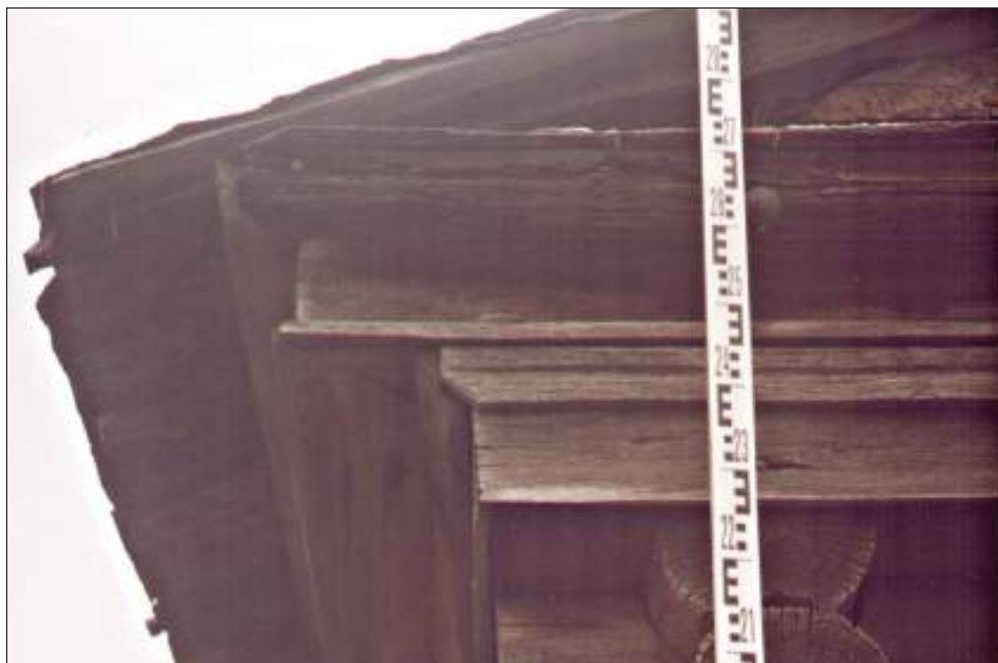
Рис. 26. ХМАО-Югра. Сургутский район, пос. Сайгатино. Дом Махневой (Очимкиной). Фрагмент северного фасада. Примыкание кровли и составного прибивного карниза
