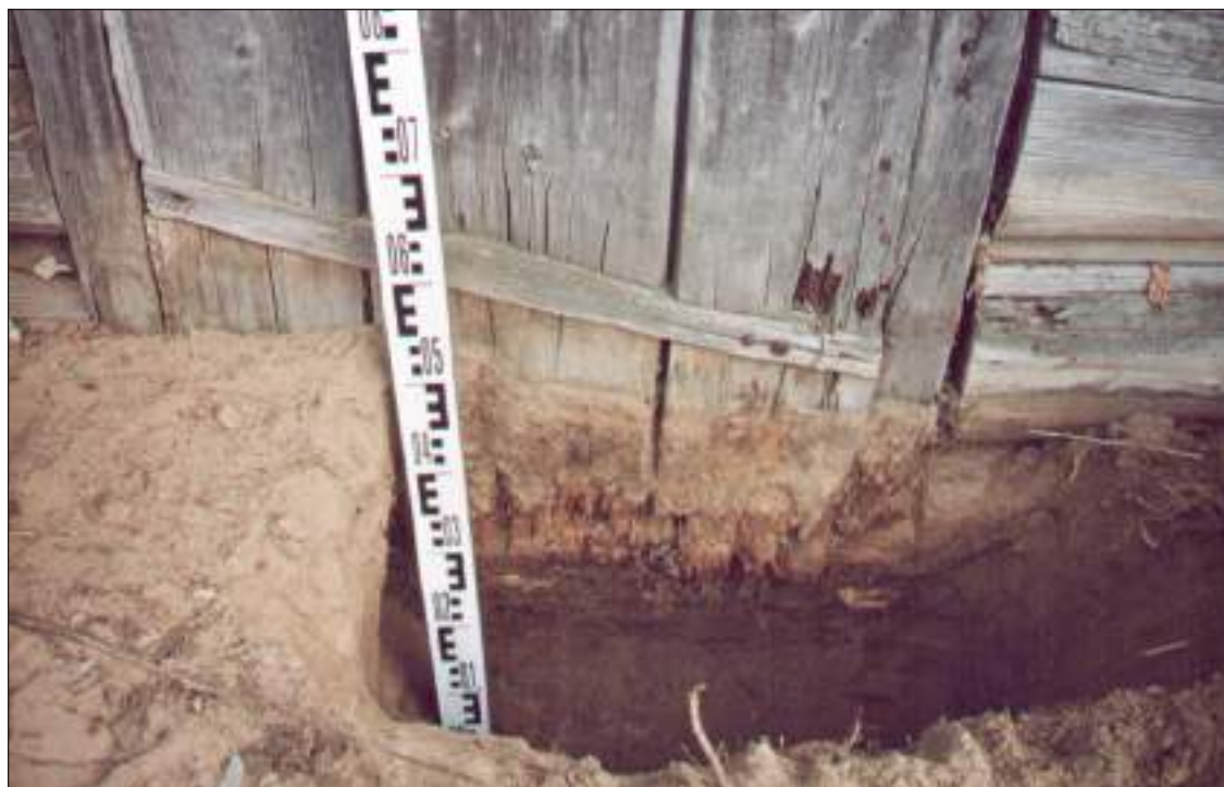
Рис. 29. ХМАО-Югра. Сургутский район, пос. Сайгатино. Дом Махневой (Очимкиной). Западный фасад. Закладка шурфа для определения низа двери утраченного прируба
