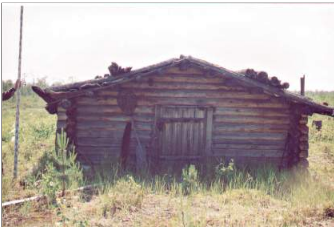
Рис. 71. ХМАО-Югра. Нефтеюганский район, юрты Пунси. Рыбный лабаз Е. Д. Каюкова. Восточный фасад Fig. 71. KhMAO-Yugra. Nefteyugansk District. Punsu yurts. Fish labaz of E. D. Kayukov. Eastern facade
