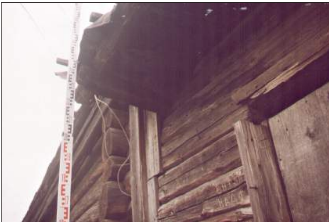
Рис. 15. ХМАО-Югра. Сургутский район, пос. Сайгатино. Дом Махневой (Очимкиной). Фрагмент южного фасада. Фрагмент прируба. Соединение бруса прируба со стойкой
