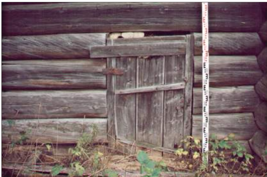
Рис. 28. ХМАО-Югра. Сургутский район, пос. Сайгатино. Дом Махневой (Очимкиной). Фрагмент западного фасада. Дверь в утраченный прируб
