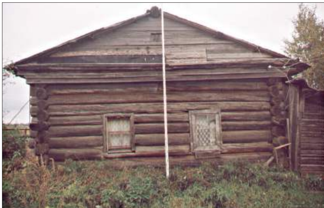
Рис. 17. ХМАО-Югра. Сургутский район, пос. Сайгатино. Дом Махневой (Очимкиной). Фрагмент южного фасада. Фрагмент прируба. Консольный вынос кровли прируба над входом
