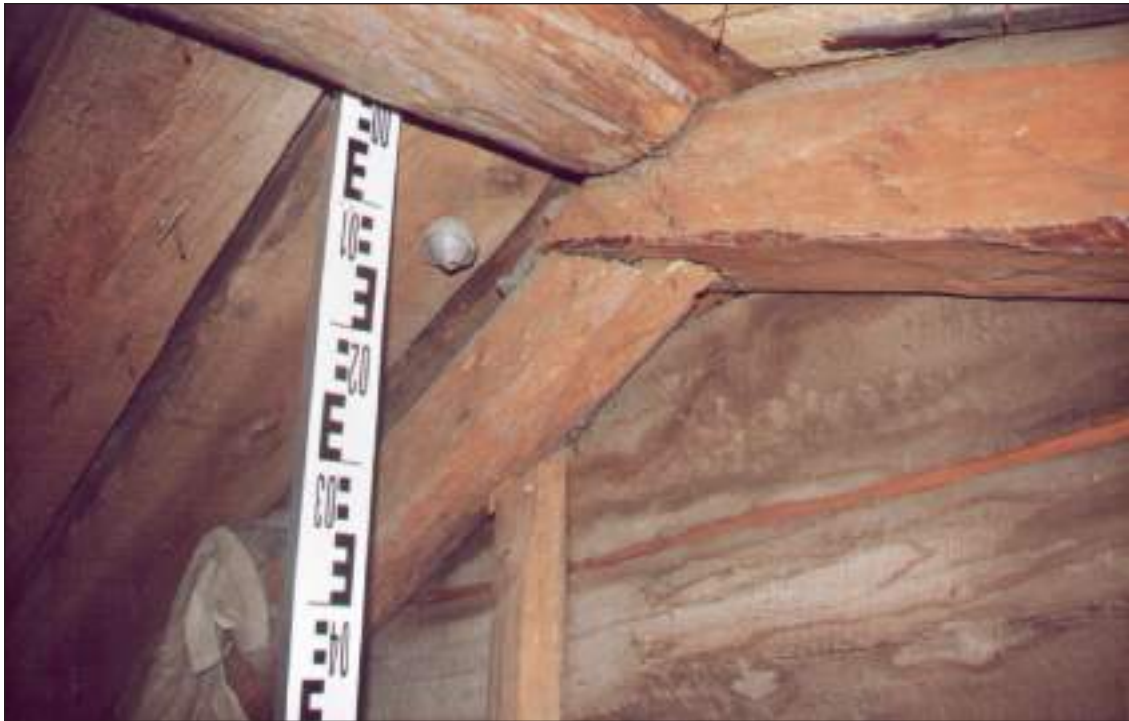
Рис. 31. ХМАО-Югра. Сургутский район, пос. Сайгатино. Дом Махневой (Очимкиной). Чердачное помещение. Врубка «замок стропильный коньковый»
