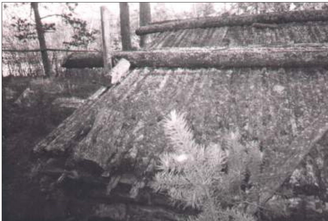
Рис. 95. ХМАО-Югра. Нефтеюганский район, юрты Пунси. Рыбацкий шалаш на реке Тапатъеге. Кровельное покрытие из жердей прижимается поперечными слегами-гнетами. Нижние гнеты и быки сгнили, видны их остатки
