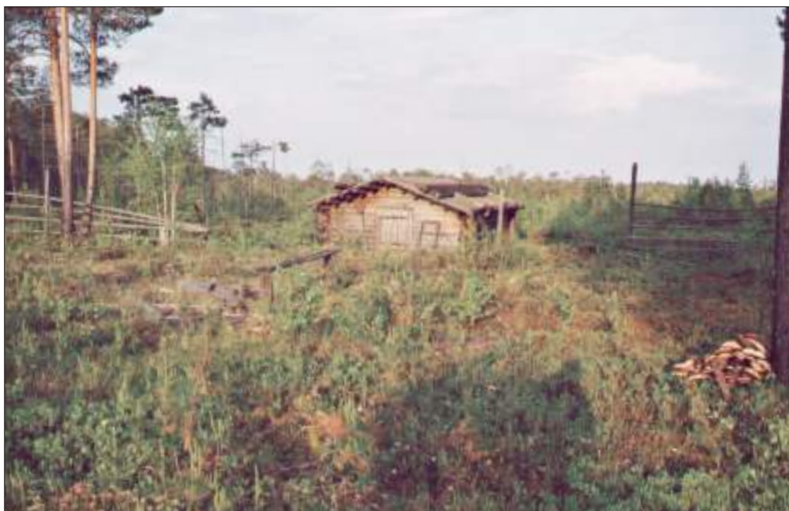
Рис. 70. ХМАО-Югра. Нefтеyуганский район, юрты Пунси. Рыбный лабаз Е. Д. Каюкова. Общий вид с дороги, с юго-запада
