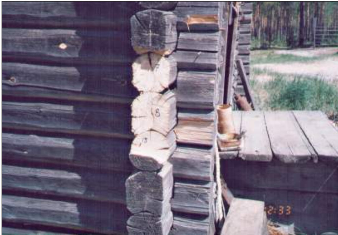
Рис. 11. Постройки усадьбы Е. Д. Каюкова датировались с применением дендрохронологического метода. Дом Е. Д. Каюкова, образцы 7, 8, 13
