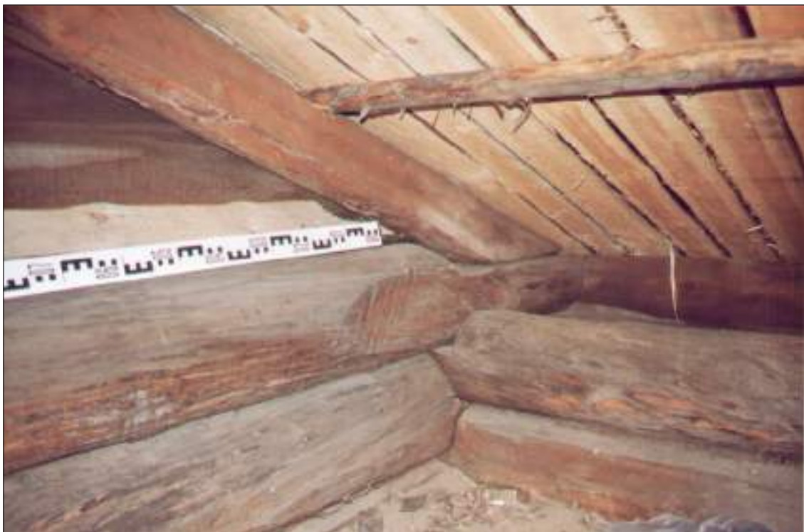
Рис. 32. ХМАО-Югра. Сургутский район, пос. Сайгатино. Дом Махневой (Очимкиной). Чердачное помещение. Врубка «замок стропильный с оборотным зубом и шипом»
